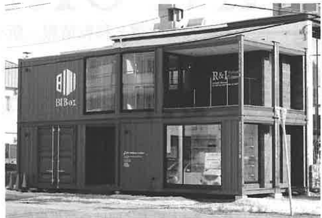
コンテナハウスを活用した本社
